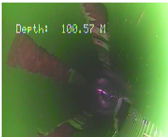
شکل شماره ۲ - نمونه ای از آسیب دیدگی لوله جدار upvc ناشی از ضربه و گذشت زمان
