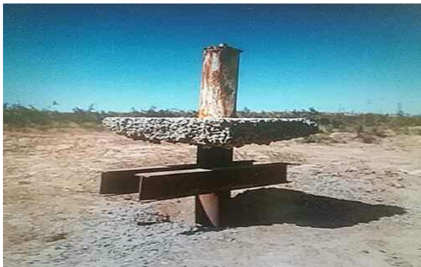
شکل شماره ۳- پدیده لوله زایی ناشی از فرونشست زمین در روستای عصمت آباد بوئین زهرای قزوین
