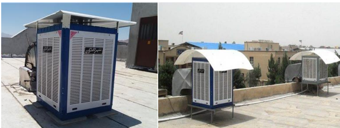
شکل ۳۰: نصب سایبان بر روی کولرهای آبی
