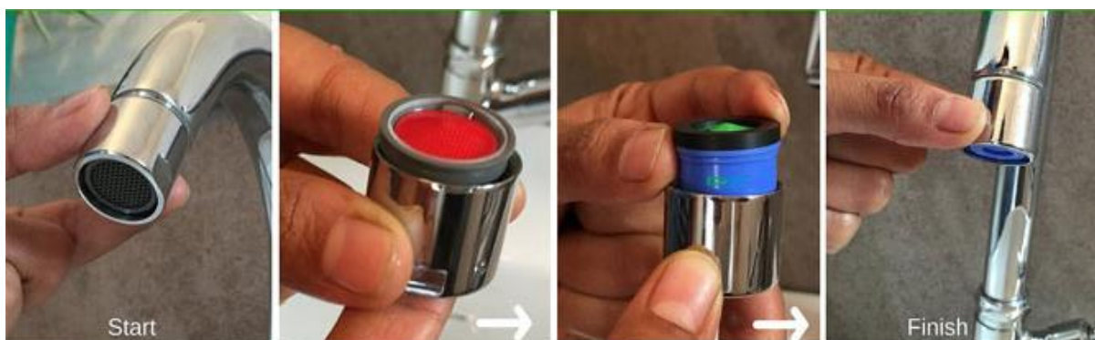
شکل ۲۴: نحوه تعویض یا نصب سرشیر
